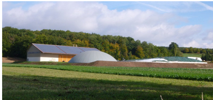
Abb. 4: Biogasanlage mit Verwaltung. Foto: Landratsamt Weißenburg-Gunzenhausen (Frau Beer)
