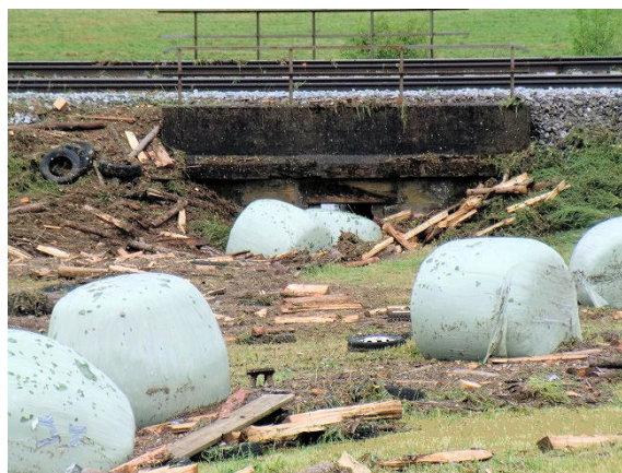
Abb. 7: Verklauung eines Durchlasses unter einer Bahnlinie mit Silageballen und Holz Foto: WWA Ansbach, 2016
