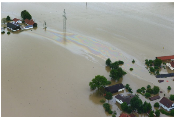
Abb. 10: Hochwasser 2013 (Inn), Schlieren von Heizöl. © Nürnberg Luftbild, Hajo Dietz
