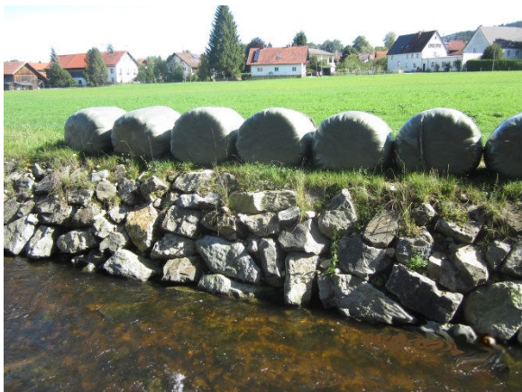
Abb. 8: Siloballen direkt am Gewässer, Verklausungsgefahr bei Hochwasser. Foto: L. Guffler, LRA Weilheim
