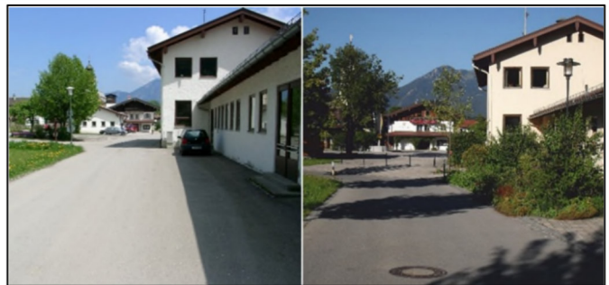
Abb. 1: Praxisbeispiel Schleching; Entsiegelung im Rahmen der Dorferneuerung (Dorfplatz Raiten links vor und rechts nach der Maßnahmenumsetzung). Quelle: Peter Oster
