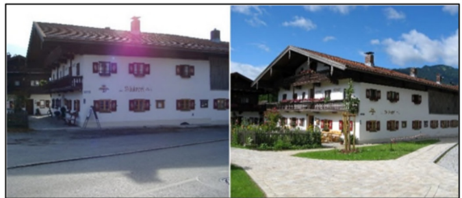
Abb. 2: Praxisbeispiel Schleching; Entsiegelung im Rahmen der Dorferneuerung (Kirchplatz/Hauptstraße Raiten links vor und rechts nach der Maßnahmenumsetzung). Quelle: Peter Oster
