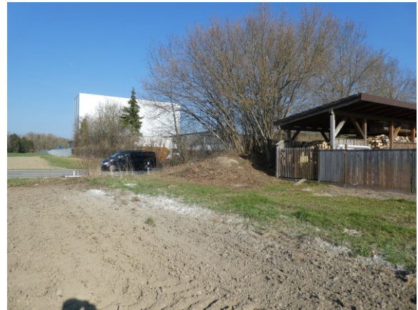
Die Ostecke des UG, von Süden aus gesehen.
